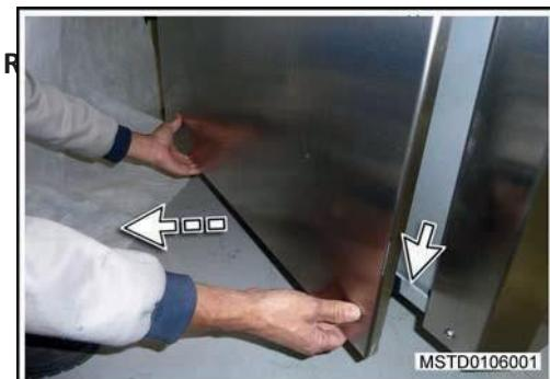
1. Com as duas mãos segure firmemente nas extremidades do painel a ser removido e puxe para fora para soltar a trava do fecho tipo "velcro" aplicado no painel e na cantoneira da estrutura.
