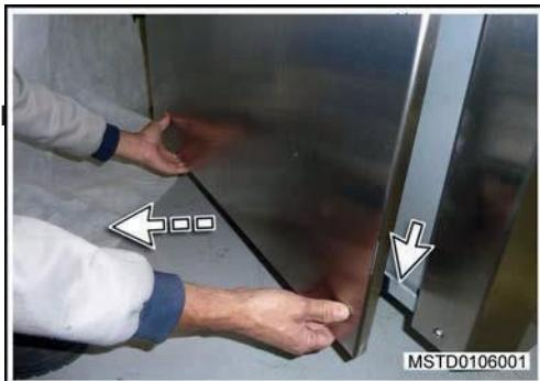
1. Remova a placa de acabamento lateral (lado do painel de controle) para ter acesso à parte traseira dos botões de comando.
